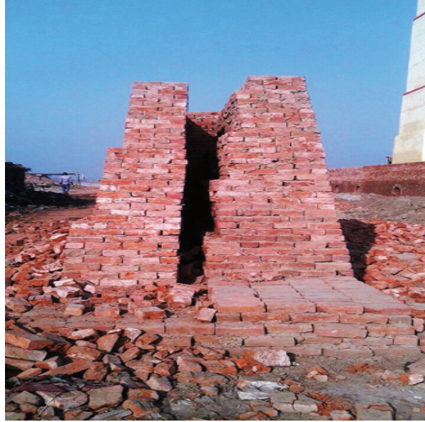
फोटो 10: भट्टे की बाहरी दीवार को बाहर की ओर सीढ़ीनुमा बनाया जाता है।
